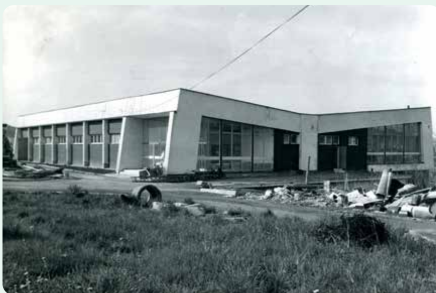
Bazén při rekonstrukci a odstranění poškozené střechy.
