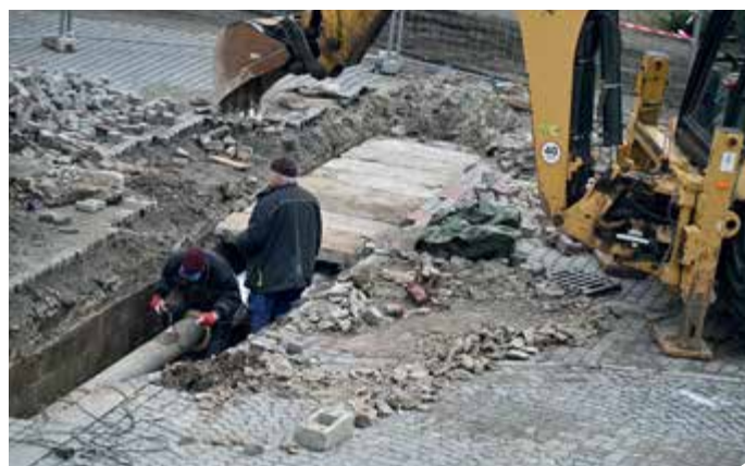
Oprava rozvodů tepla v centru města.
