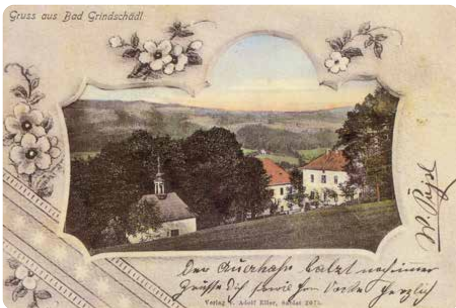
Dobrá Voda u Záblatí (Bad Grindschädl) na dobové pohlednici
