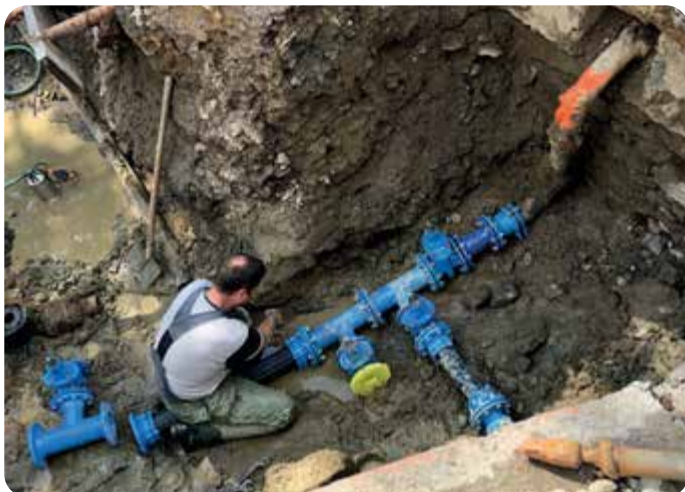
Než byl položen povrch, došlo i na vodu a kanalizaci.
