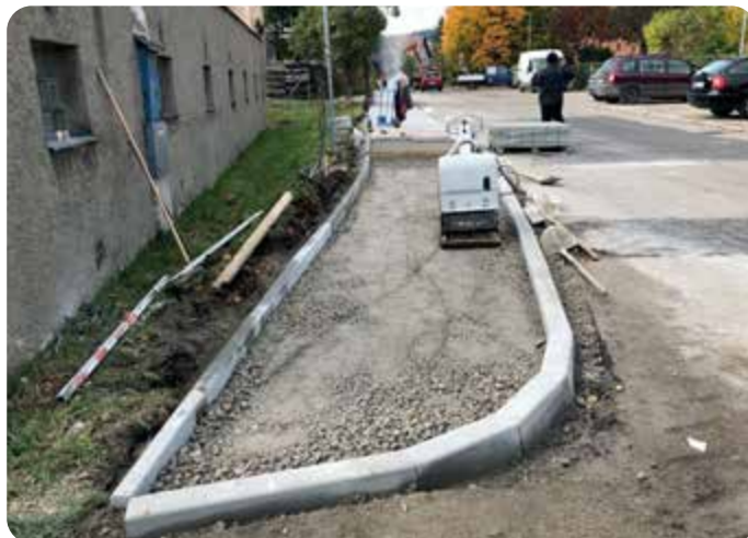
Práce v ulici Mlýnská.
